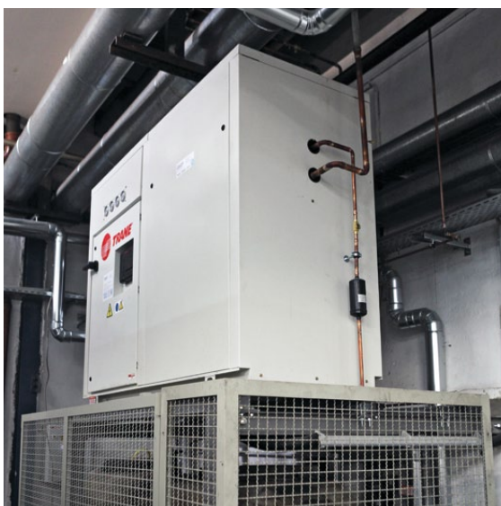
Dieses Gerät liefert die notwendige Prozesskälte für die Pressen. An einem Wochenende musste die Technik neu eingerichtet und angepasst werden.
