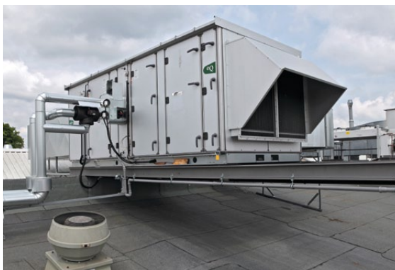
Leistungsfähige Lüftungsanlagen auf dem Dach.
