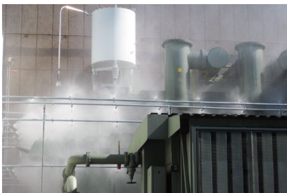
So sieht es im Ernstfall aus, wenn die Sprühnebelanlage zu löschen beginnt.
