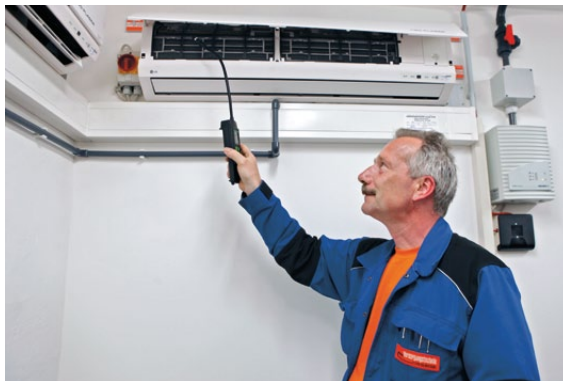
Servicemonteur Fred Werner prüft die Luftaustrittstemperatur.
