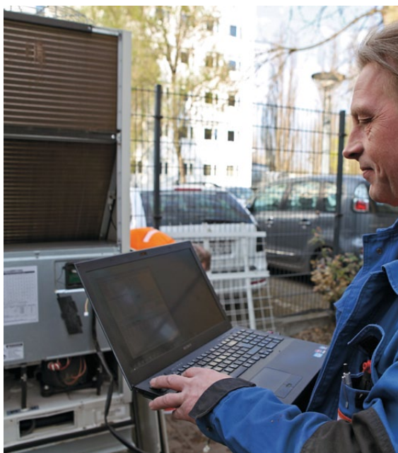
Datenüberwachung und Kontrolle der Kältetechnik am Laptop.
